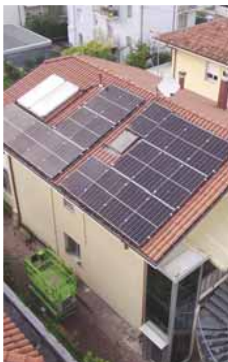
Impianti fotovoltaici di Anythink Building
